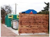
Une dalle de propreté a été réalisée sous les poubelles de l'espace tri de la petite rue blanche. La pose de brise vues finalise cette remise en état. Espérons que ces travaux inciteront les utilisateurs à être plus précautionneux.
