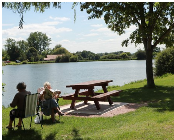
Réalisation de dalles de propreté pour mise hors d'eau des tables de pique-nique de l'étang
